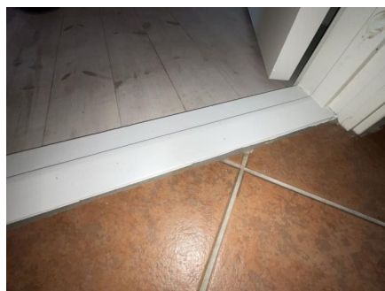
Overgang ved dørterskel.
