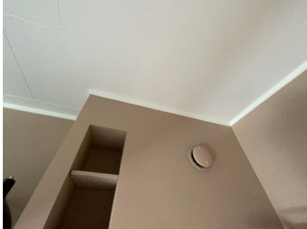
Lufteluke i opprinnelig kanal (tidligere kjøkken).
