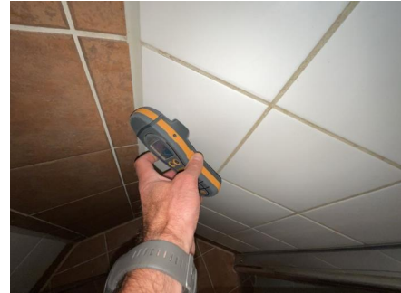
Fuktsøk med Protimeter fuktapparat.
