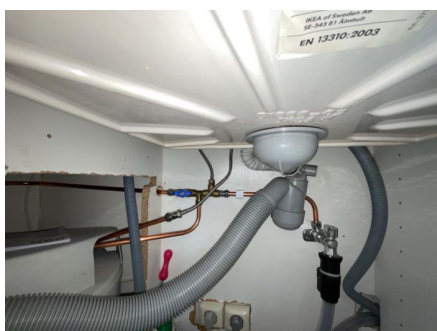
Rørøplegg på kjøkken.
