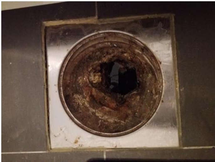
Membran, tettesjikt og overgang til sluk. - [Sluk i baderom.]
