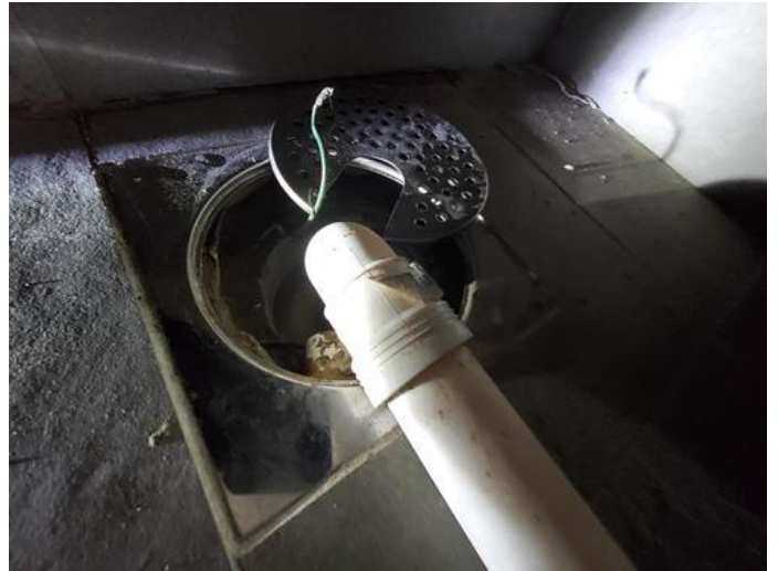
Membran, tettesjikt og overgang til sluk. - [Bad 1.etasje - Sluk]
