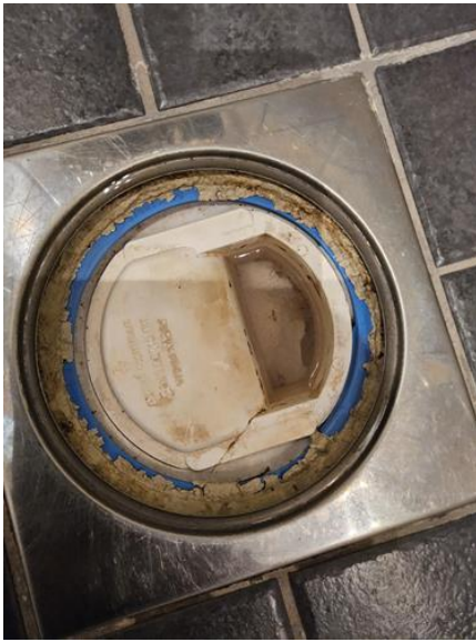
Membran, tettesjikt og overgang til sluk. - [Sluk]
