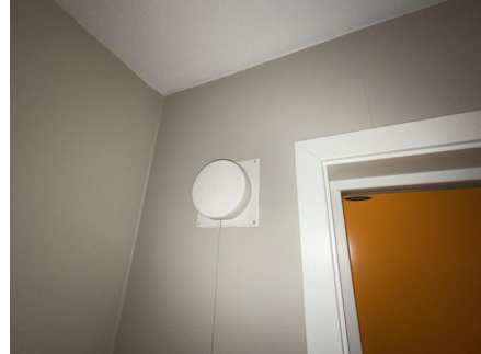
Lufteventil i yttervegg.
