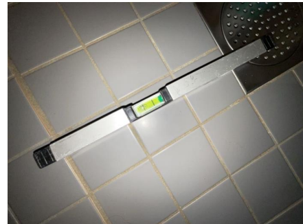
Fallforhold målt i retning sluk.
