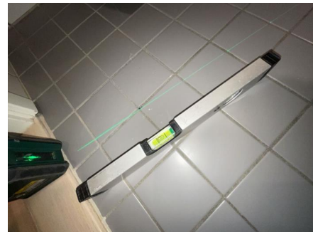
Fallforhold målt i retning sluk.
