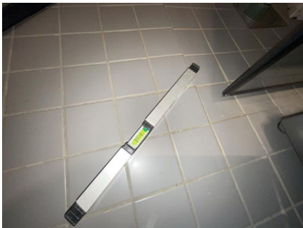
Fallforhold målt i retning sluk.
