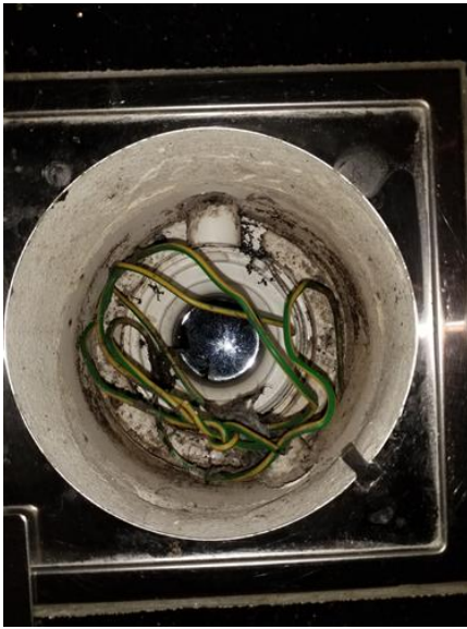
Membran, tettesjikt og overgang til sluk. - [Hovedsluk bad ]
