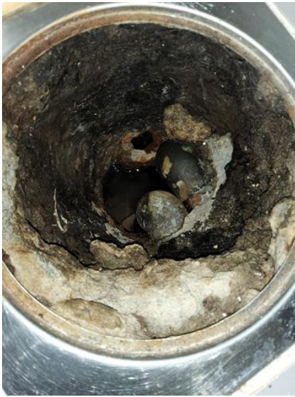
Våtrom - [Sluk bad ]
