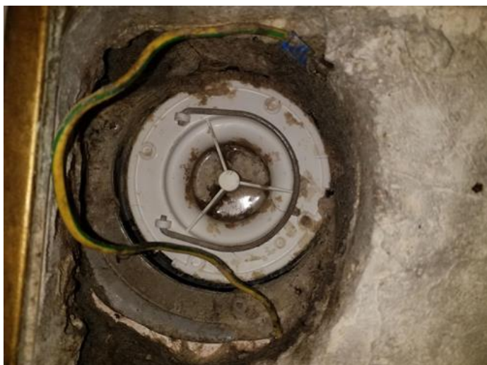
Membran, tettesjikt og overgang til sluk. - [Hovedsluk i bad 1.]
