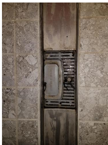
Membran, tettesjikt og overgang til sluk. - [Hjelpesluk i dusjsone i bad 2.]
