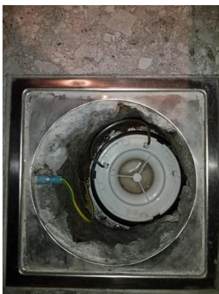
Membran, tettesjikt og overgang til sluk. - [Hovedsluk i bad 2.]
