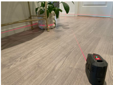
Nivellering entré, avvik ca. 10-20 mm
