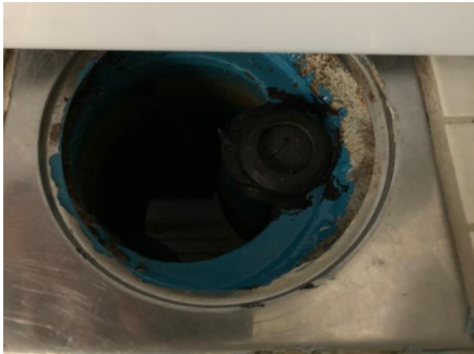
Baderomssluk plassert på gulv ved dusjkabinett.
