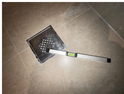
Fallforhold målt i retning sluk.
