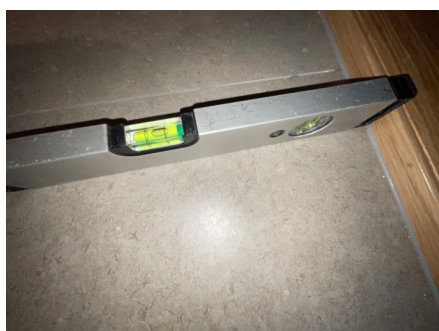
Fallforhold målt i retning sluk.
