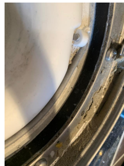
Slukmansjett klemt i klemring i sluk
