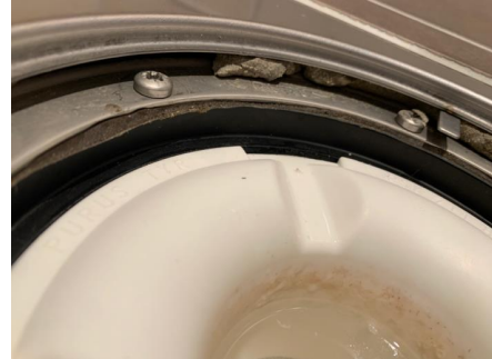
Synlig slukmansjett klemt i klemring i sluk
