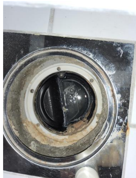
Membran, tettesjikt og overgang til sluk. - [Sluk under badekar bad]
