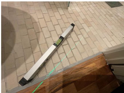
Fallforhold målt i retning sluk.
