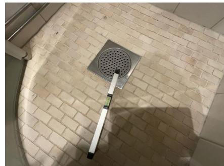
Fallforhold målt i retning sluk.
