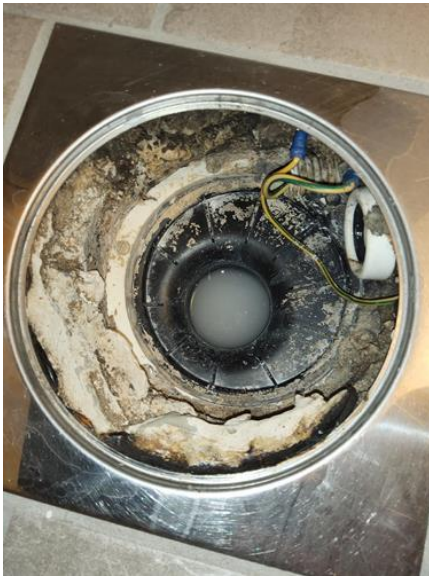
Våtrom - [Sluk bad ]
