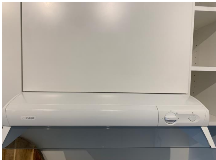
Sjellventilator over kokesone
