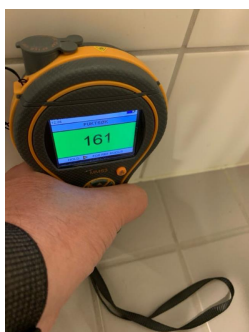
Fuktmåling overflater baderom.
