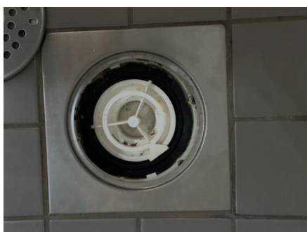
Baderomssluk plassert i dusjonen
