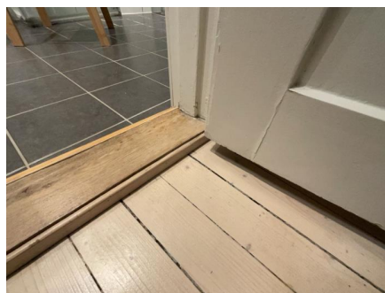
Luftespalte under dørrbladet.
