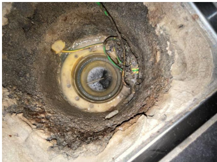
Hovedsluk under servant.
