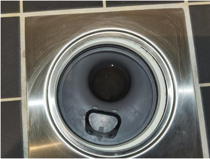
Membran, tettesjikt og overgang til sluk. - [Sluk]
