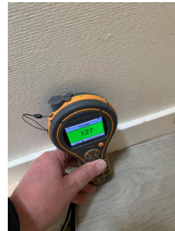
Fuktighets måling tilliggende rom.
