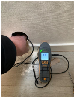
Hulltaking med fuktmåling bad/vaskerom
