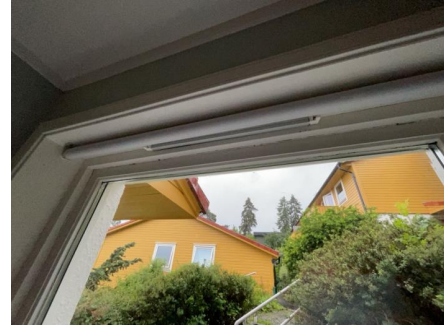
Luftespalter over vinduer.
