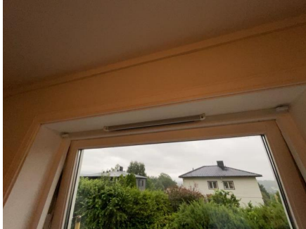
Luftespalter over vinduer.
