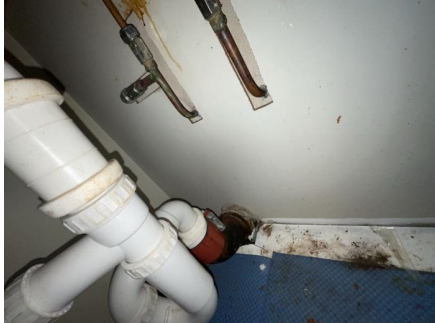
Avløpsrør i vegg på kjøkken.
