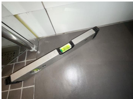
Fallforhold målt i retning sluk.
