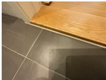
Overgang ved dørterskel.
