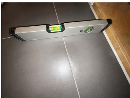
Fallforhold målt i retning sluk.
