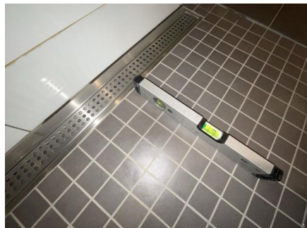
Fallforhold målt i retning sluk.
