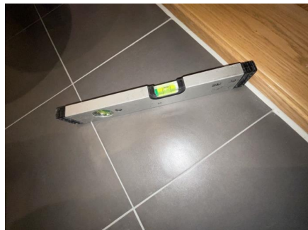
Fallforhold målt i retning sluk.
