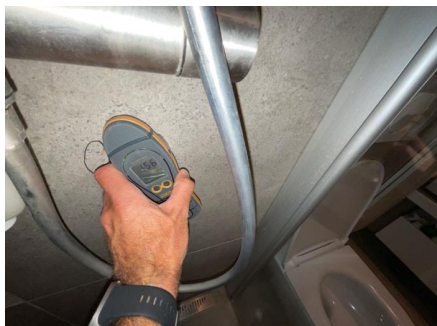
Fuktsøk med Protimeter fuktapparat.
