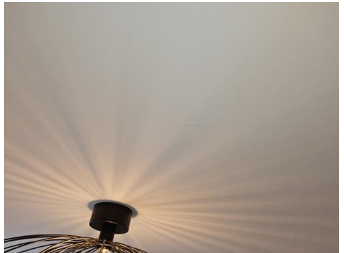
Kommentar - [Sprekk/riss i himling]
