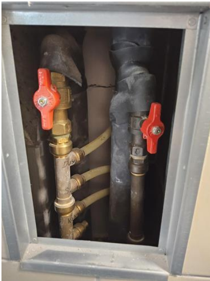
Vannrør - [Fordelerstamme med stoppekraner]
