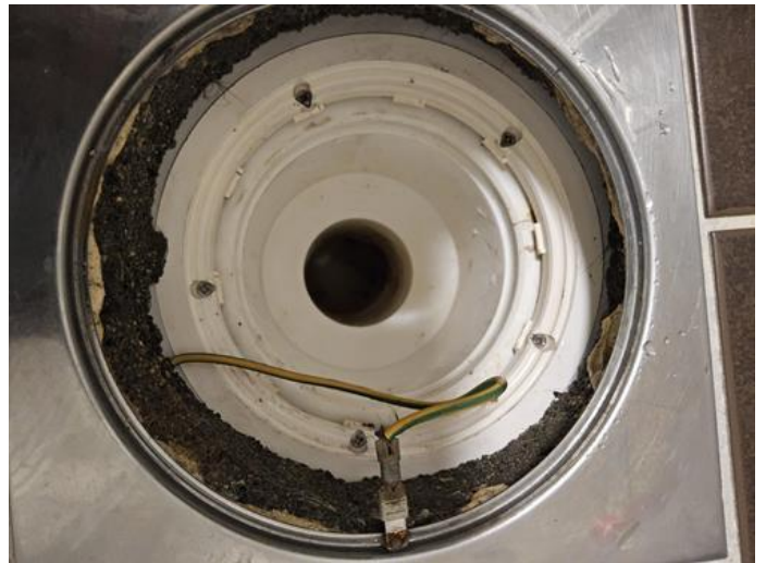
Avløpsrør (ink. sluk) - [Sluk i dusj]
