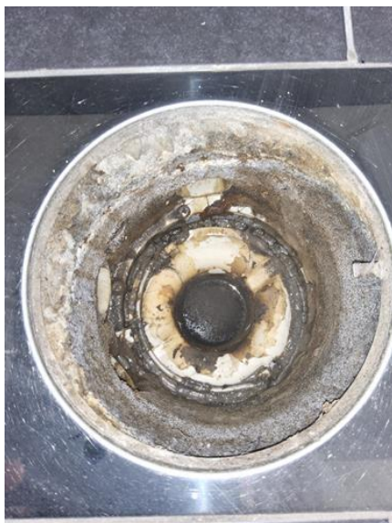
Membran, tettesjikt og overgang til sluk. - [Hovedsluk]
