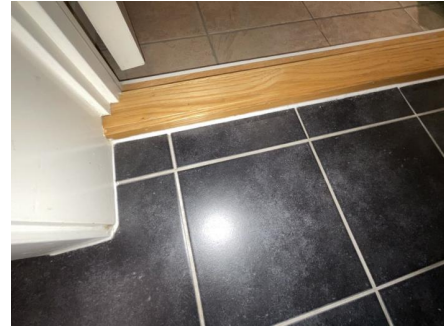
Overgang ved dørterskel.
