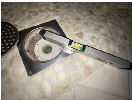
Fallforhold målt i retning sluk.
