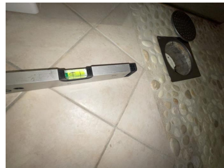
Fallforhold målt i retning sluk.
