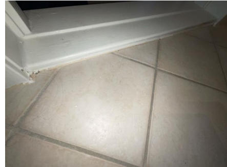
Overgang ved dørterskel.
