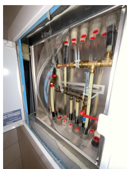
Rør på kjøkken. Lekkasjesensor.
