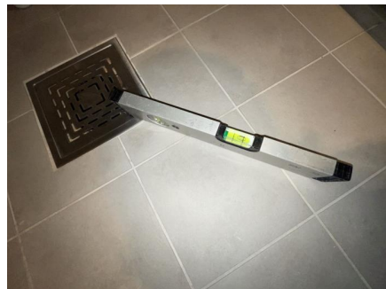
Fallforhold målt i retning sluk.
