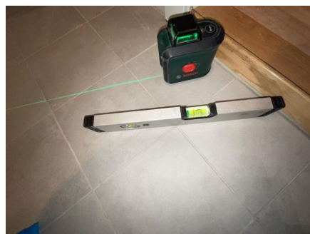
Fallforhold målt i retning sluk.
