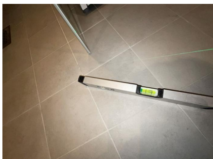
Fallforhold målt i retning sluk.
