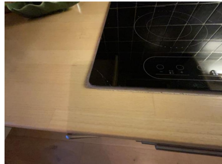
Sprekk i koketopp.
