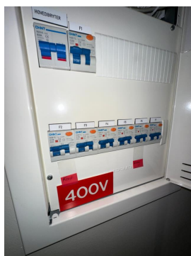
Sikringsskap med automatsikringer.
