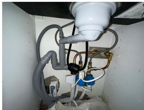
Rørapplegg i kjøkkenbenk med Waterguard
