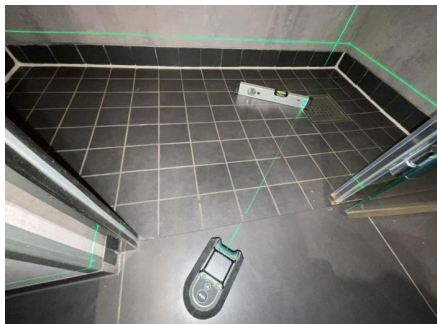
Fallforhold målt i retning sluk.
