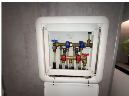
Innerste beskyttelses lokk mangler.
