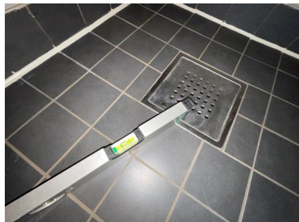
Fallforhold målt i retning sluk.
