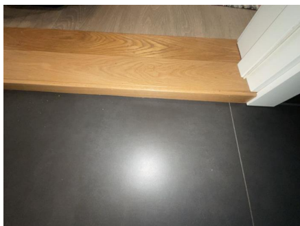
Overgang ved dørterskel.
