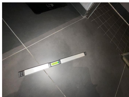
Fallforhold målt i retning sluk.
