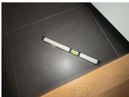
Fallforhold målt i retning sluk.
