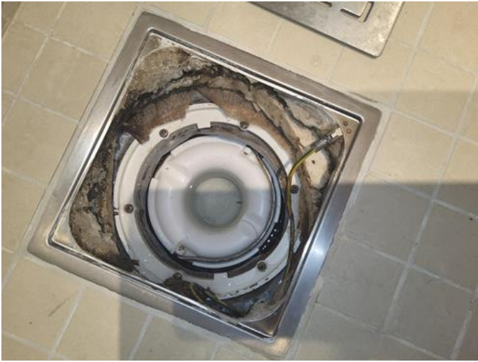
Membran, tettesjikt og overgang til sluk. - [Sluk bad underetasje 4]
