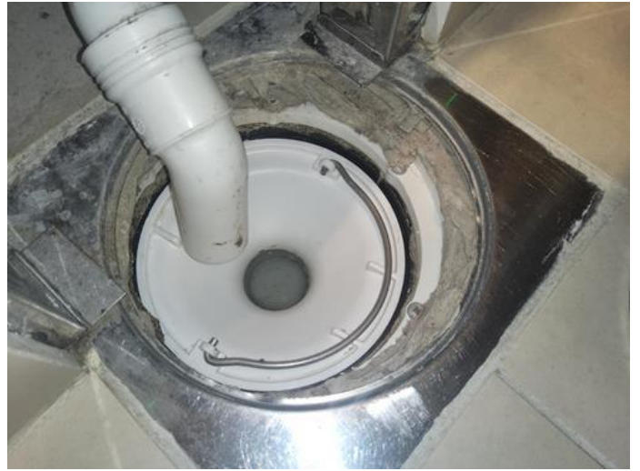
Membran, tettesjikt og overgang til sluk. - [Sluk bad underetasje 5]
