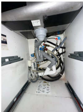
Rørapplegg i kjøkkenbenk med Waterguard
