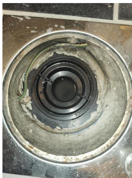
Våtrom - [Sluk vaskerom ]
