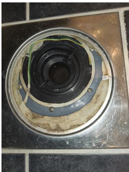
Våtrom - [Sluk bad underetasje ]
