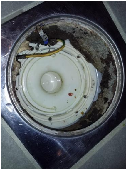
Membran, tettesjikt og overgang til sluk. - [Sluk i dusjsone. Bad 2.etasje. ]
