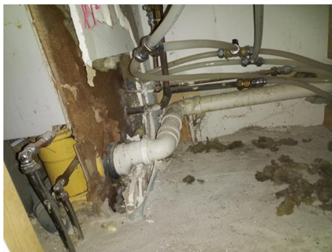
Kommentar - [Vannrør i kasse på bad.]
