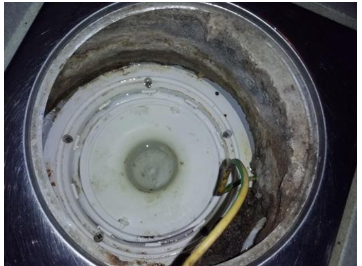
Membran, tettesjikt og overgang til sluk. - [Sluk i bad. 2.etasje. ]
