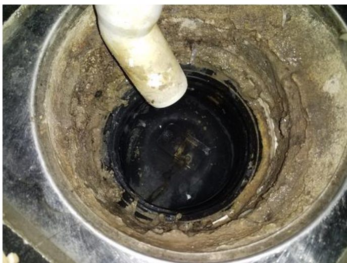
Membran, tettesjikt og overgang til sluk. - [Sluk i bad. 1. etasje.]
