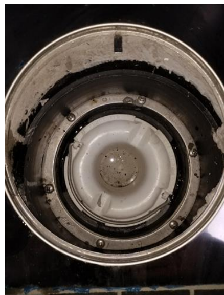
Membran, tettesjikt og overgang til sluk. - [Sluk bad 2.etasje ]
