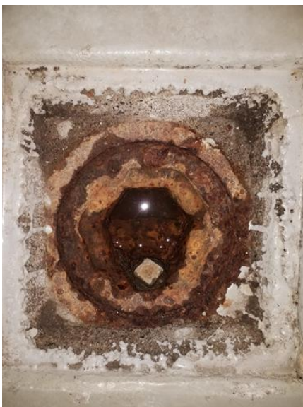
Avløpsrør. (Sjekkpunkter utover det som er inkludert i andre rom) - [Sluk underetasje ]
