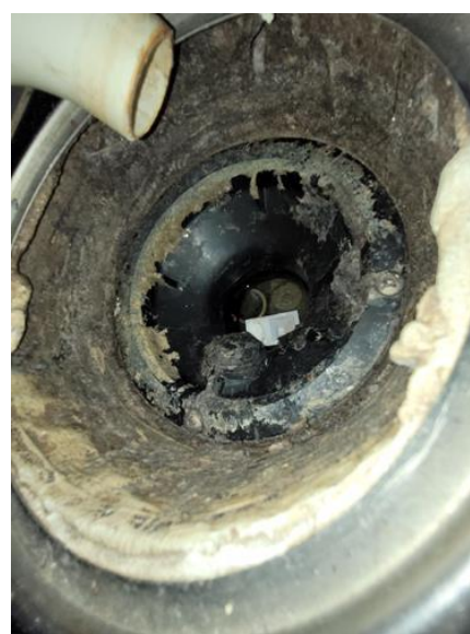
Membran, tettesjikt og overgang til sluk. - [Sluk bad anneks]
