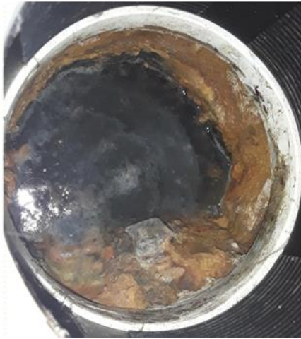
Våtrom - [Sluk under dusjkabinett - Baderom]
