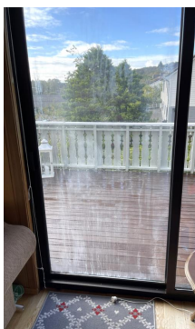
Punktert glass i balkongskyvedør.
