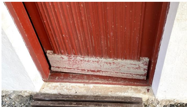
Overflateslitt kjellerdør
