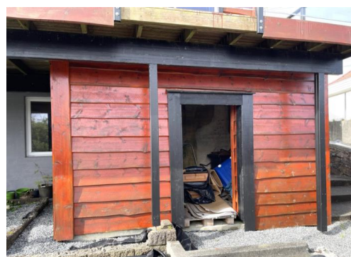
Åpent skur (tidligere brønn)
