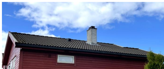
Takflate mot nord-øst sett fra bakkenivå.
