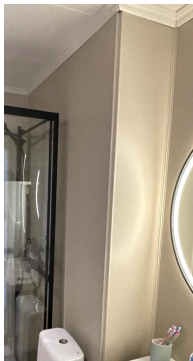
Dobbelvegg mellom dusj og kjøkkeninnredning.
