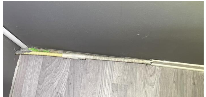
Synlig trekkør på det store soverommet.
