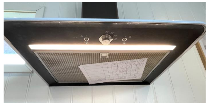
Ventilator bestod papirtesten
