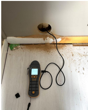
Hullboring bak kjøleskap på kjøkken
