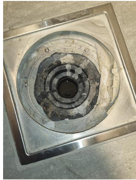
Våtrom - [Sluk vaskerom ]
