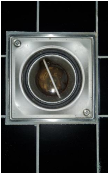
Membran, tettesjikt og overgang til sluk. - [Sluk bad 2]
