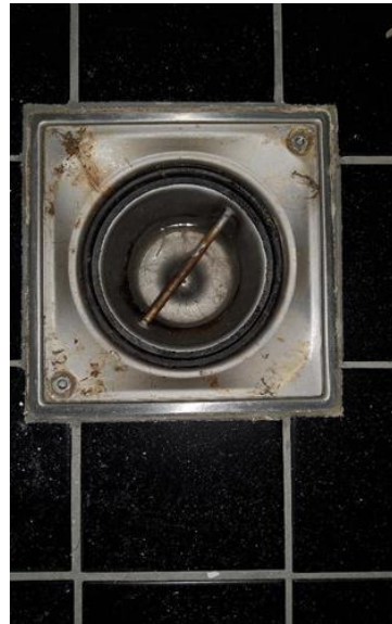
Membran, tettesjikt og overgang til sluk. - [Sluk bad 1]
