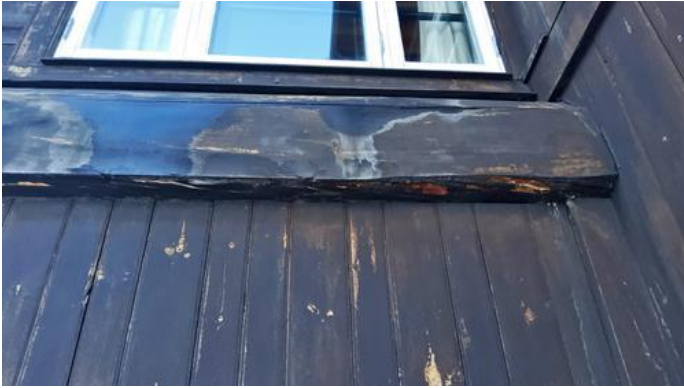
Fasader ink. kledning - [Gammelseterlia - Yttervegg (14.03.2024)]
