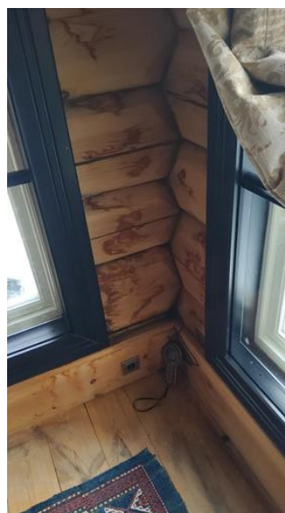
Overflater vegger - [Gammelseterlia - Øvrige rom 1.ETG - Veggflater (14.03.2024)]
