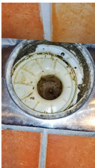
Avløpsrør (ink. sluk) - [Gammelseterlia - Vaskerom - Sluk (14.03.2024)]
