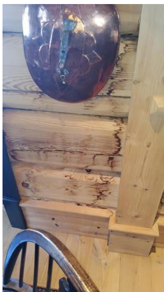
Overflater vegger - [Gammelseterlia - Kjøkken - Vegg (14.03.2024)]
