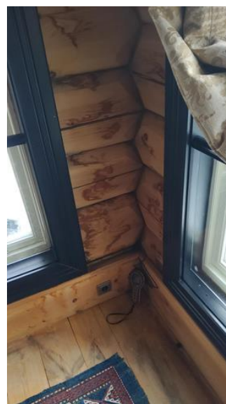
Overflater vegger - [Gammelseterlia - Øvrige rom 1.ETG - Veggflater (14.03.2024)]
