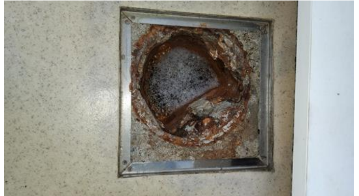
Membran, tettesjikt og overgang til sluk. - [Sluk bad 1 etg.]
