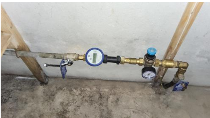
Hovedstoppekran - [Stoppekraner i bod 2 i underetasje ]
