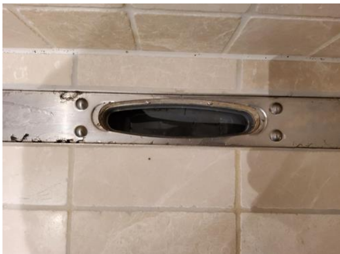
Membran, tettesjikt og overgang til sluk. - [Sluk]
