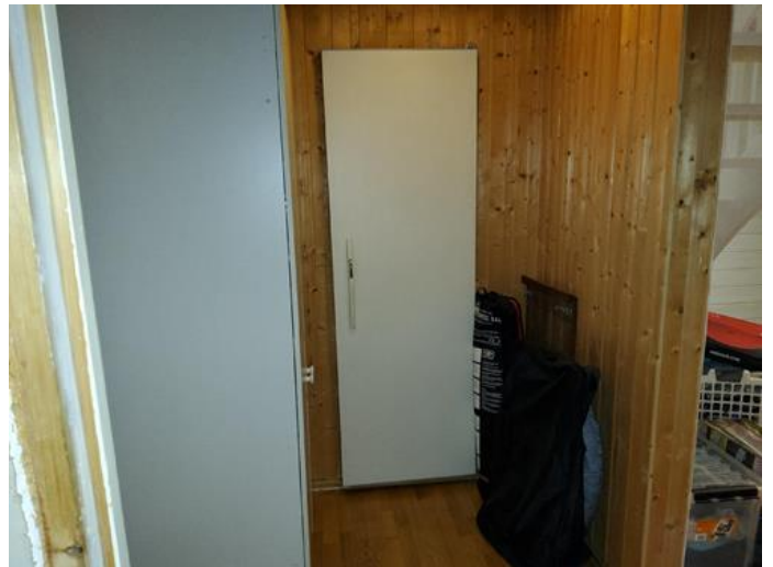
Tekniske anlegg, VVS anlegg (Sjekkpunkter utover det som er inkludert i andre rom) - [Kjølerom]
