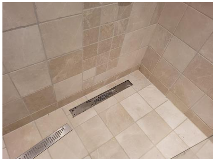
Membran, tettesjikt og overgang til sluk. - [Sluk]
