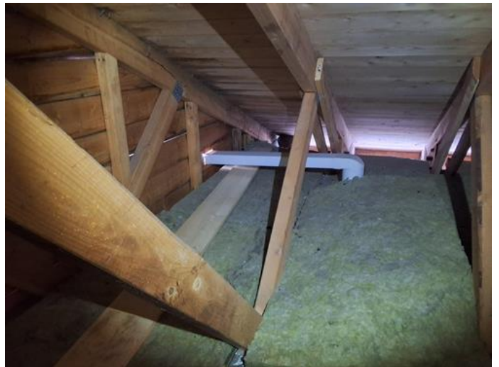
Loft - uinnredet / råloft - [Loft]
