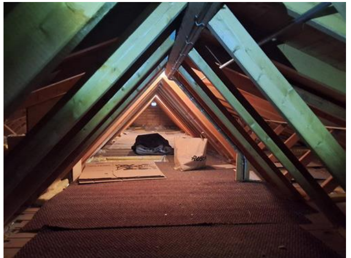
Loft - uinnredet / råloft - [Loft]
