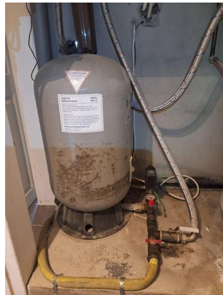
Hovedstoppekrane - [Trykktank og stoppekrane.]
