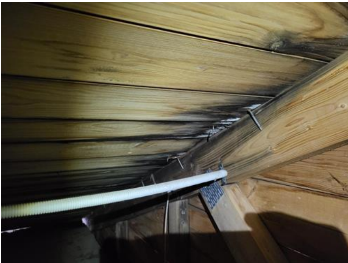
Loft - uinnredet / råloft - [Loft]
