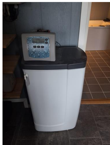
Vannrør (Sjekkpunkter utover det som er inkludert i andre rom) - [Filterløsning til vann.]
