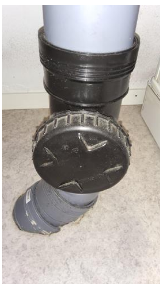
Stakeluke - [Stakeluke på hovedstamme tilgjengelig i kjeller]
