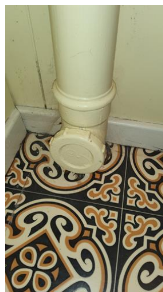
Stakeluke - [Stakeluke på avløpsrør fra kjøkken, tilgjengelig i kjeller]
