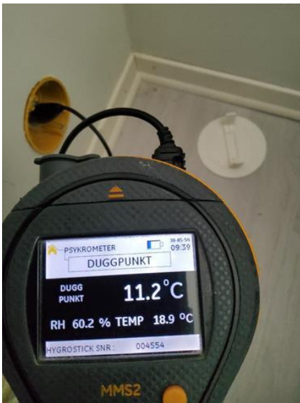
Rom under terreng (kjeller, underetasje, sokkeletasje) - [Fuktmåling i kjellervegg]
