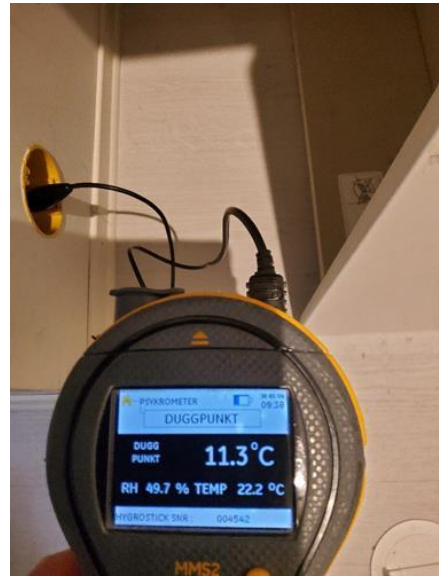
Våtrom - [Fuktmåling på bad U. etg.]
