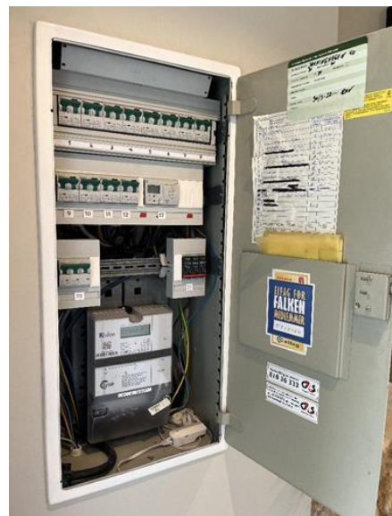
Elektrisk anlegg - [Sikringskapet i 1. etg.]
