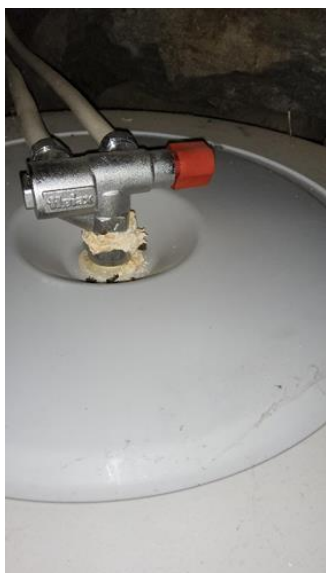
Varmtvannsbereder (Sjekkpunkter utover det som er inkludert i andre rom) - [Mineralansamling rundt blandeventil - Varmtvannsbereder]
