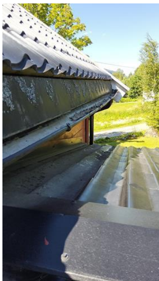
Beslag, renner, nedløp og snøfangere - [Feilmontert takfotbeslag/skadet takrenne - Yttertak hoveddel]
